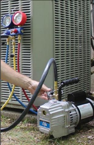
La válvula del manómetro aísla la bomba del sistema cuando se está haciendo prueba de fugas. Incluye tres puertos de entrada, 1/4", 3/8" SAE y 1/2" ACME en los modelos de 5 y 7.5 CFM.
