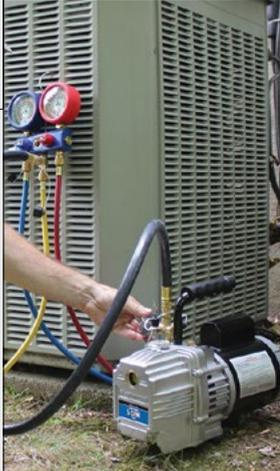
La valvola di gruppo manometrico isola la pompa dal sistema Include tre attacchi - da 1/4", 3/8" SAE e 1/2" ACME nei modelli 5 e 7.5.
